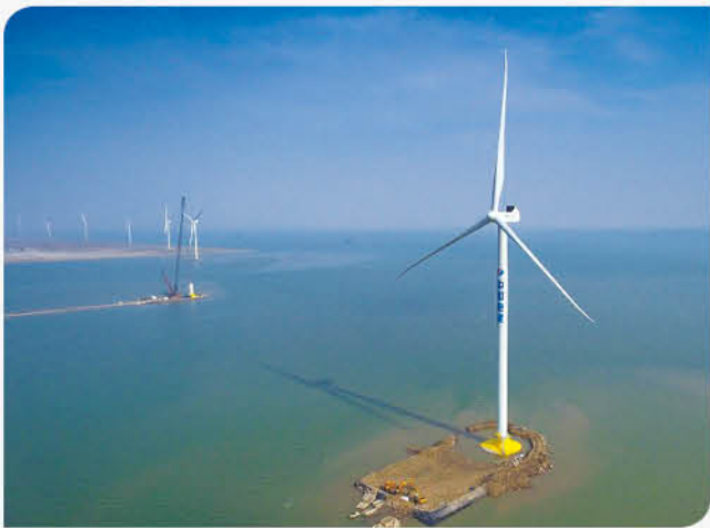
△ 建设银行天津市分行支持天津首个海上风电项目首批发电机并网发电
