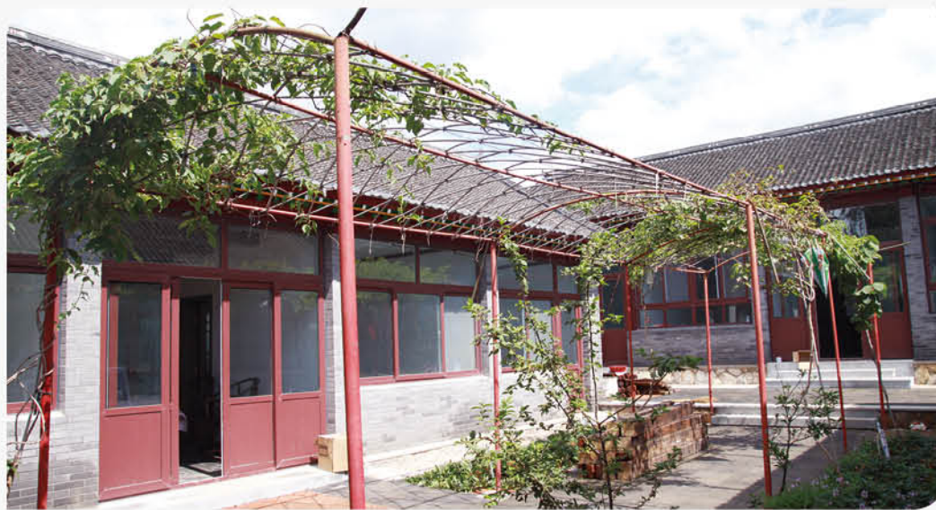
△ 天津银行蓟州支行支持的农家院改造项目
