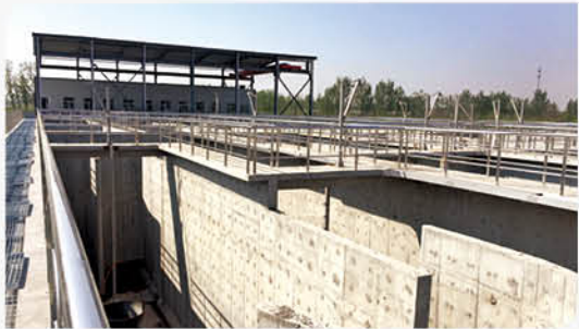
△ 招商银行天津分行支持万庄新城再生水厂工程建设
